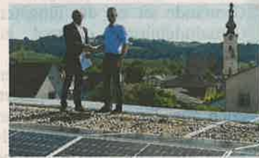
▲ Auf dem Schulgebäude wurde bereits eine PV-Anlage installiert.
