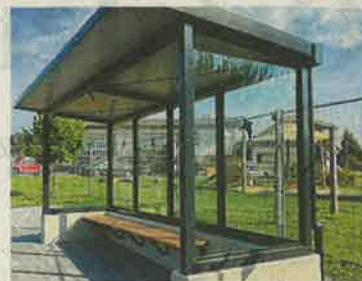
Das neue Buswartehäuschen bietet vor allen Wetterereignissen Schutz. Foto: BVZ
